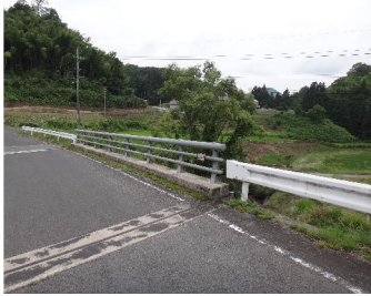
れ曲止。わを防す。狙ルト難。がボ盗ま。橋ボして。のボして。地すたり。間ま行。山間策。
