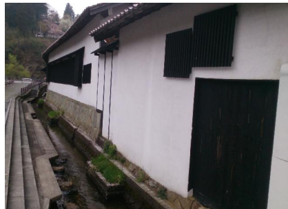
田部家旧屋敷南面、白漆喰塗り壁。手前側が東側。現在水路も整備され田部城下町の趣を醸している。
