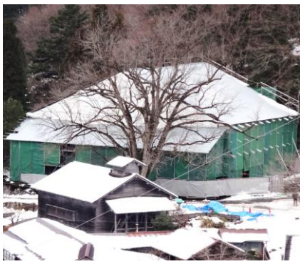
大きなテントに覆われた菅谷高殿解体中随時見学会が行われる。
