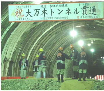
建設によるトンネル施工の老舗飛島建設と佐藤工業の両社による貫通の万歳！と握手。
