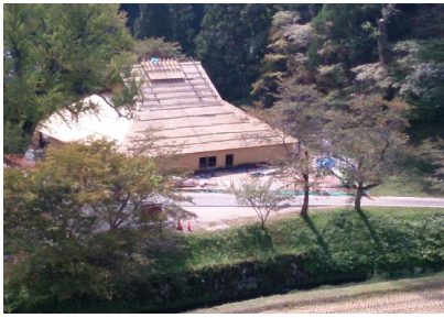
菅谷高殿。平成の匠の技で見事に復元されました。30日オープン予定。
