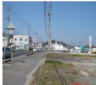
突然の工事凍結報道に困惑移転が完了し、工事再開が待たれる54号線の拡幅
